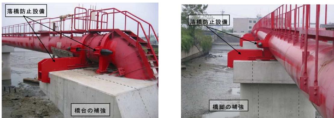
図 3-20 水管橋耐震補強の事例（名和水管橋）
