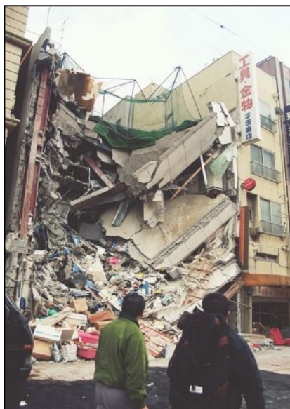
(図表2-20)アスベストを含有している可能性のあるがれき
