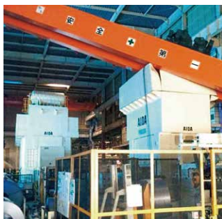
クレーン落下によりプレス機が損傷
