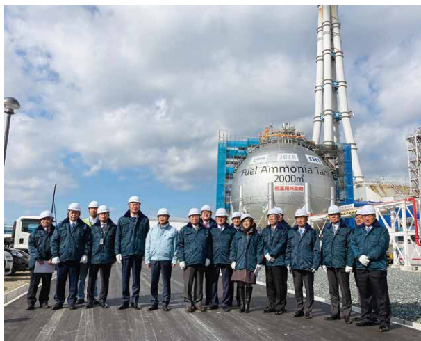
碧南火力発電所のアンモニア貯蔵タンクを視察する様子。
