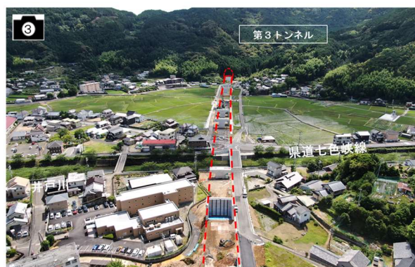
③ 施工状況(熊野道路) 出典:中部地方整備局より提供
