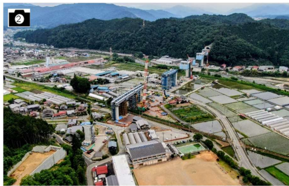
施工状況 (高山清見道路)
