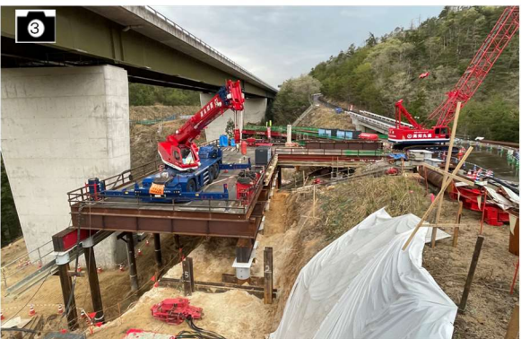
施工状況(新名神高速道路) 出典：NEXCO西日本より提供
