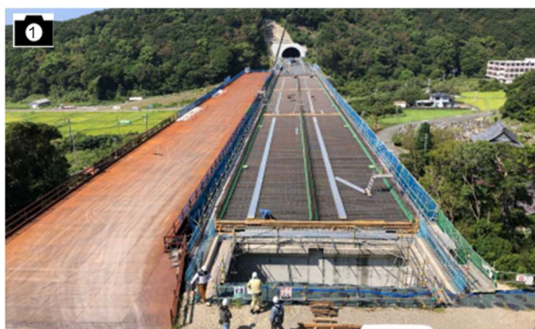
① 施工状況(すさみ串本道路) 出典:近畿地方整備局HPより
