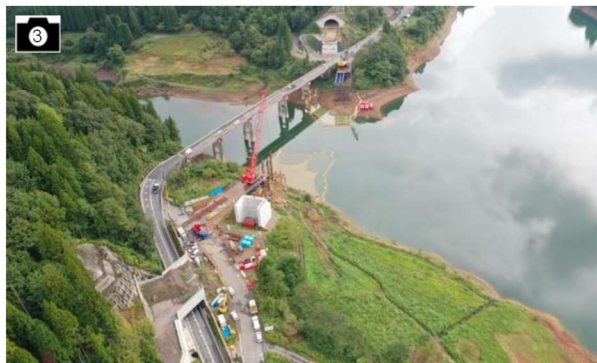
施工状況 (大野油坂道路)
