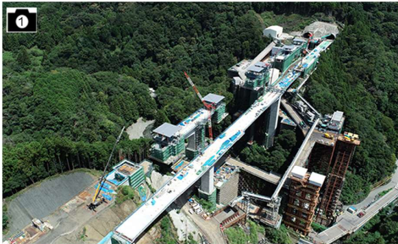
施工状況(新東名高速道路) 出典：NEXCO中日本より提供
