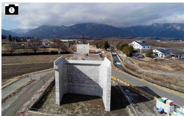
施工状況 (松本波田道路)
