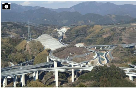
供用状況(新清水JCT) 出典:山梨県HP
