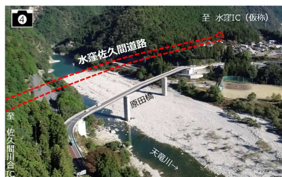
④ 現況(水窪佐久間道路) 出典: 中部地方整備局より提供
