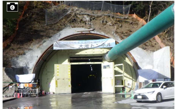
4 施工状況 (大滝トンネル) 出典:埼玉県HP
