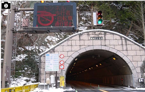
3 供用状況 (雁坂トンネル) 出典:山梨県より提供
