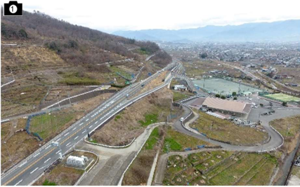
1 供用状況 (Ⅰ期区間(桜井～万力)) 出典:山梨県より提供
