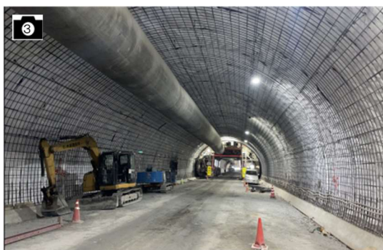
③ 施工状況(青崩峠道路) 出典: 飯田国道事務所HP
