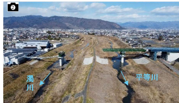
施工状況 (東部区間Ⅱ期)
