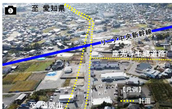
施工状況(飯田北改良) 出典:長野県より提供
