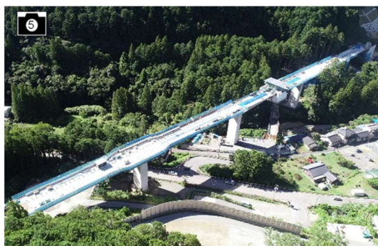
⑤ 施工状況(佐久間道路・三遠道路) 出典: 浜松河川国道事務所HP
