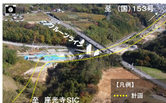
施工状況(座光寺上郷道路) 出典:長野県より提供
