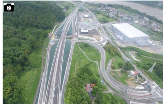
供用状況(南部IC) 出典:甲府河川国道事務所HP
