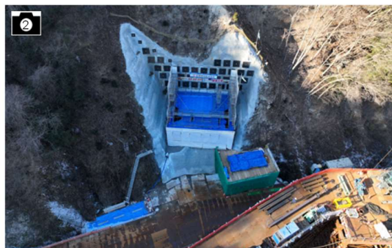
② 施工状況(飯喬道路) 出典: 中部地方整備局より提供
