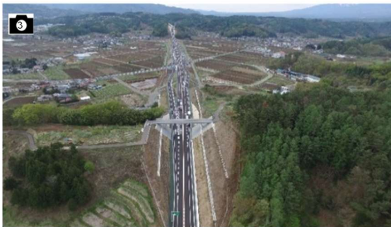
供用状況(佐久臼田IC) 出典:関東地方整備局より提供
