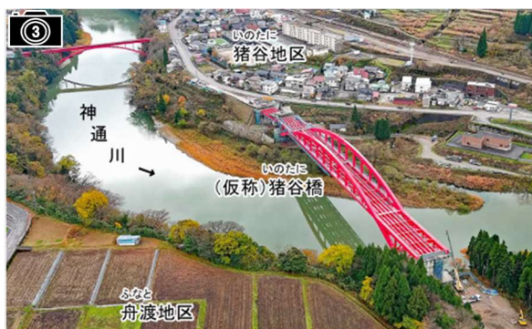
施工状況(猪谷楡原道路) 出典:北陸地方整備局HP
