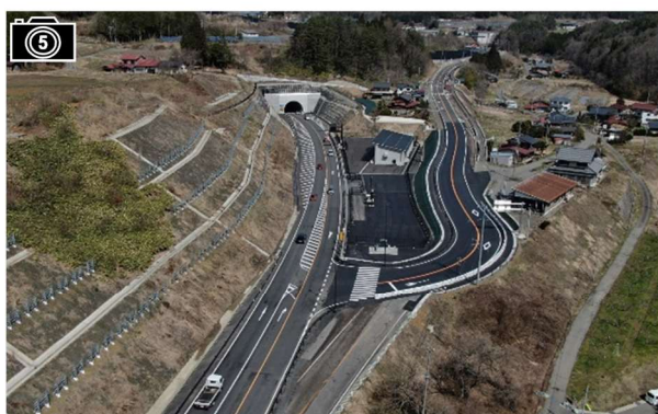
供用状況(石浦バイパス:宮峠トンネル) 出典:高山国道事務所HP
