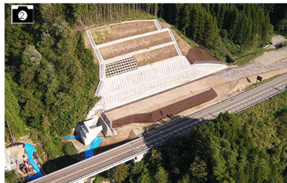
施工状況（白川郷IC-五箇山IC） 出典：NEXCO中日本より提供
