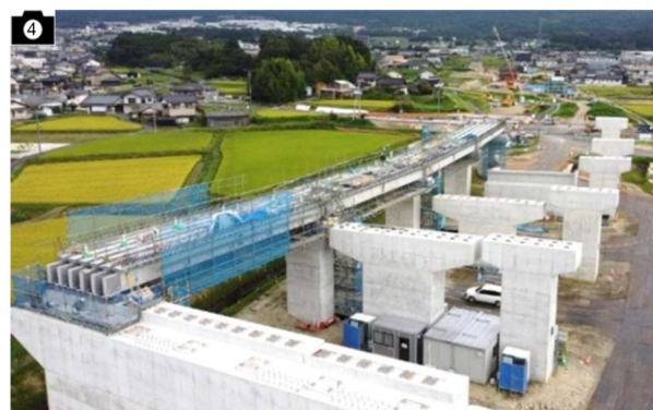
施工状況(中津川工区) 出典:岐阜県より提供
