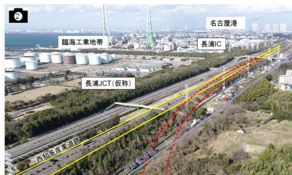
現況(長浦～日長) 出典：中部地方整備局より提供
