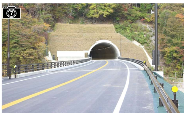
供用状況(小坂久々野バイパス) 出典:高山国道事務所HP
