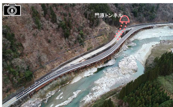
施工状況(門原防災) 出典:高山国道事務所HP
