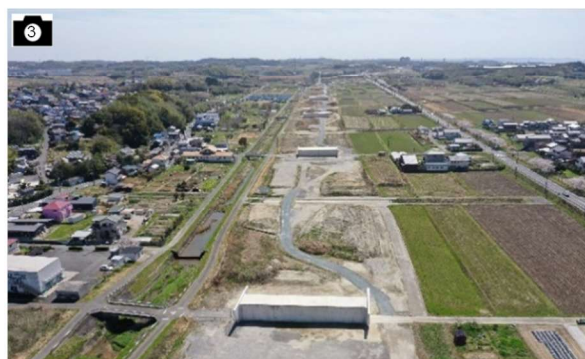
施工状況(日長～常滑) 出典：愛知県より提供
