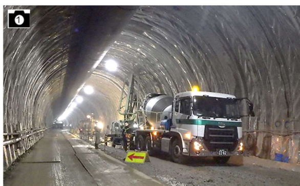
施工状況（白川郷IC-五箇山IC） 出典：NEXCO中日本より提供
