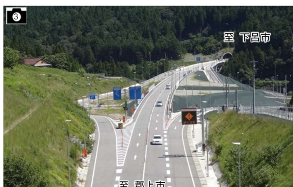
供用状況(和良・下呂間) 出典:岐阜県より提供
