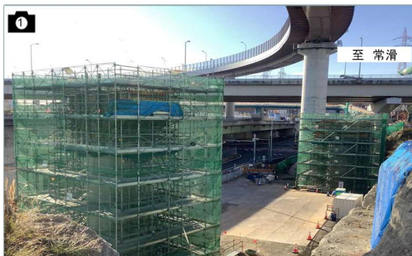
施工状況(東海JCT) 出典：中部地方整備局より提供
