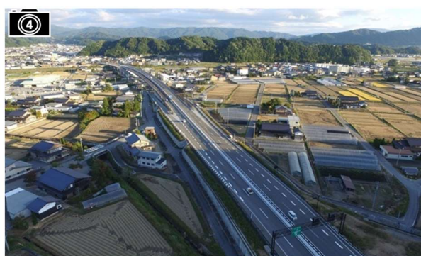
供用状況(高山国府バイパス) 出典:高山国道事務所HP
