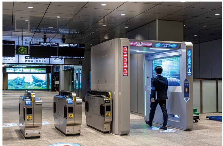
進むまちづくり。大阪駅(うめきた地下口)には、ゲートのない顔認証改札機が設置されている。Mykemykaも利用したいらしい!? ★
