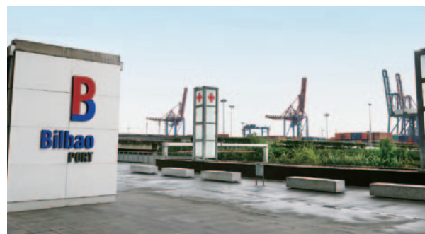
ビルバオ港外観
