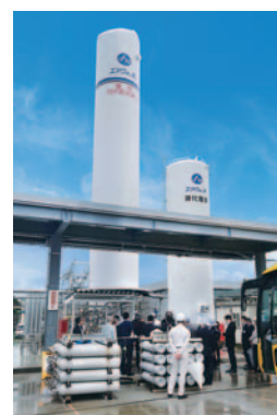
バイオガスプラント
