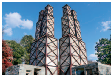
保存修理工事終了後の葦山反射炉
