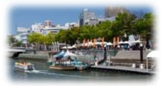
親水護岸の利用 (新町川／徳島市)
