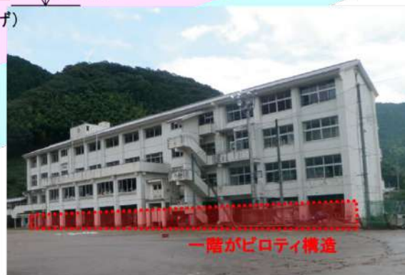
ピロティ構造の事例
