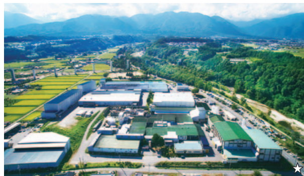
清涼な気候と豊富でおいしい地下水脈に注目し、1979年に原野を新規造成して建設した飯島グリーン工場
