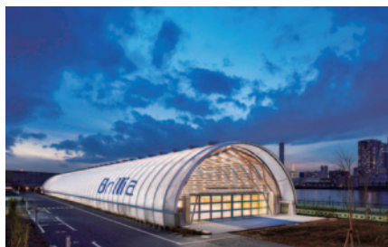
新豊洲 Brillia ランニングスタジアム (ETFEフィルム膜構造)
