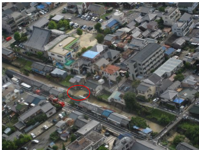
岡崎市 伊賀川の護岸崩落箇所
