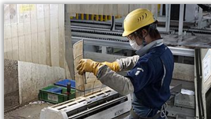
エアコンの解体
