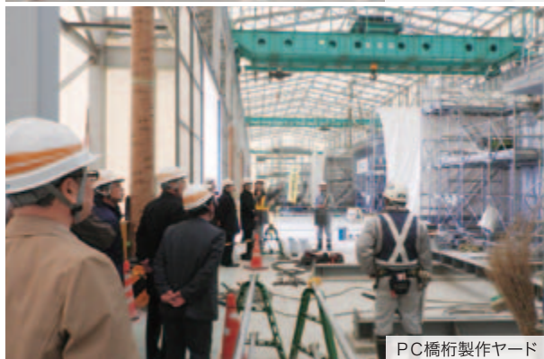
PC橋桁製作ヤード
